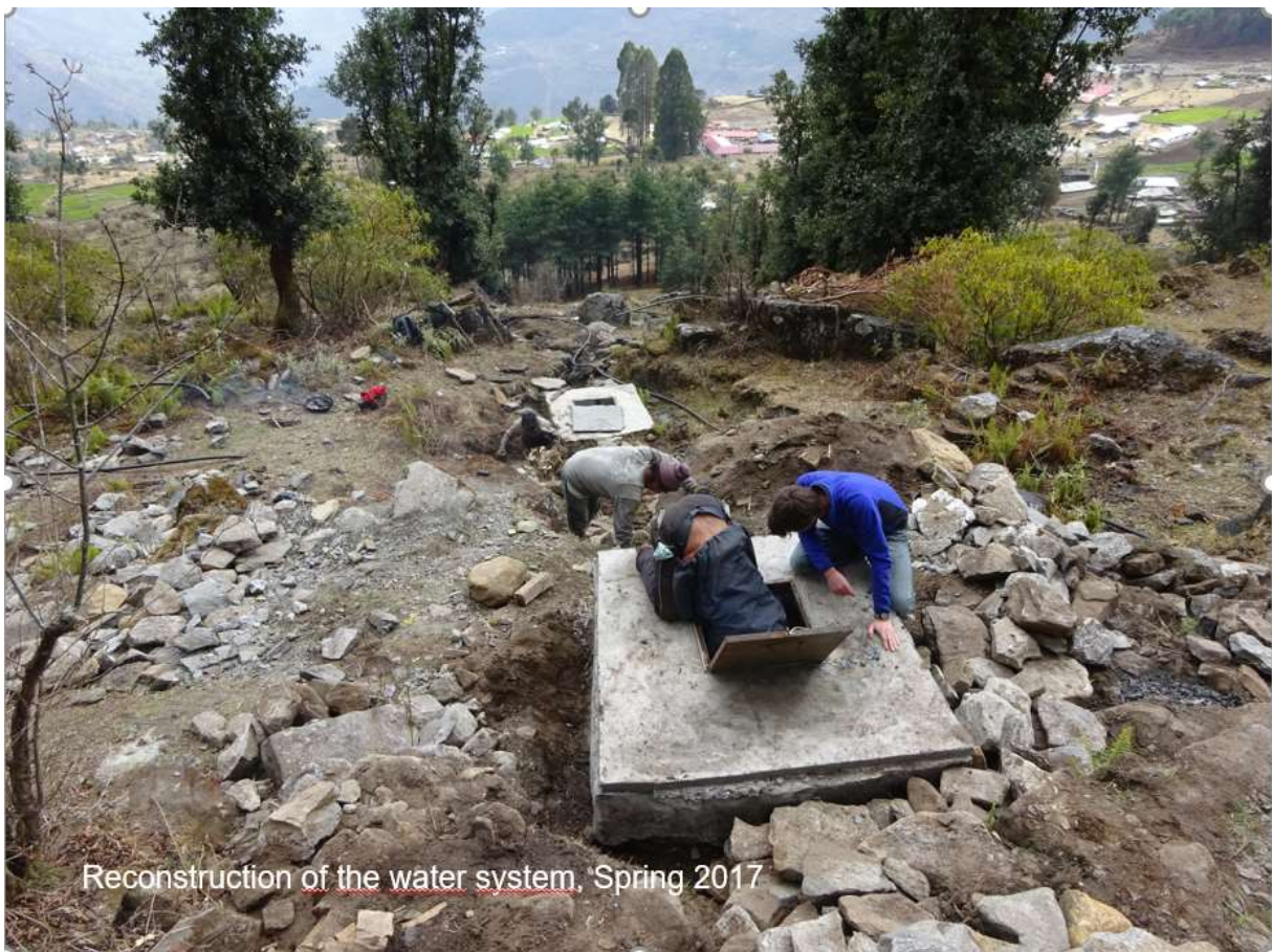
Wiederaufbau der Wasserleitung Frühjahr 2017
